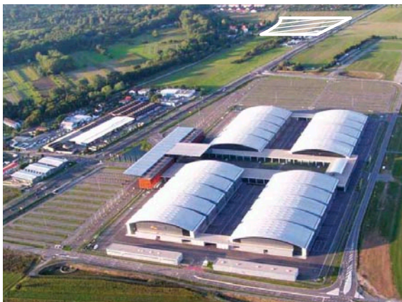
Gewerbegebiet „Neue Messe“: Direkt bei der Neuen Messe Karlsruhe an der Gemarkungsgrenze zu Rheinstetten mit einer Größe von 3,5 ha.
