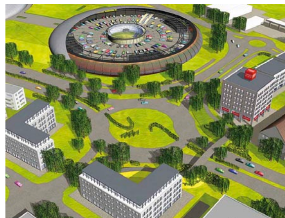
Entwicklungs- gesellschaft Cité mbH Baden-Baden: Das ehemalige Hauptquartier der französischen Streitkräfte in Deutschland mit einer Gesamtfläche von 50 ha bietet Raum für ca. 5.000 Bewohner sowie für Gewerbe und Handel.
